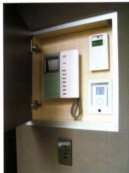
Dans une baie de gestion technique du système domotique, une station d'accueil pour iPod. Grâce à elle, le contenu musical d'un baladeur iPod est accessible et peut être écouté depuis toutes les pièces de la maison.
