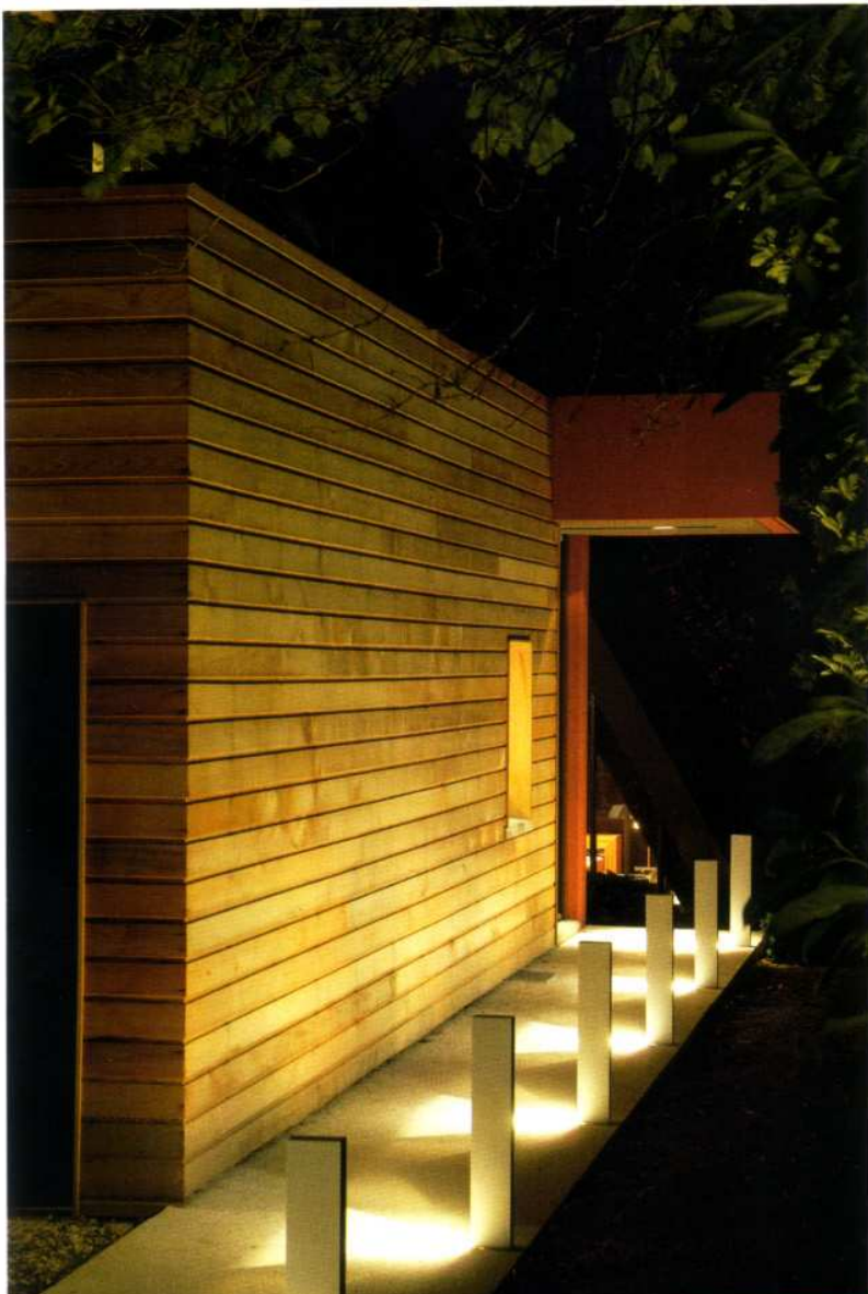
La nuit, lorsque vient un visiteur, il est repéré par un système de radars et un chemin s'illumine automatiquement à son passage, plot après plot afin d'accompagner ses pas.
